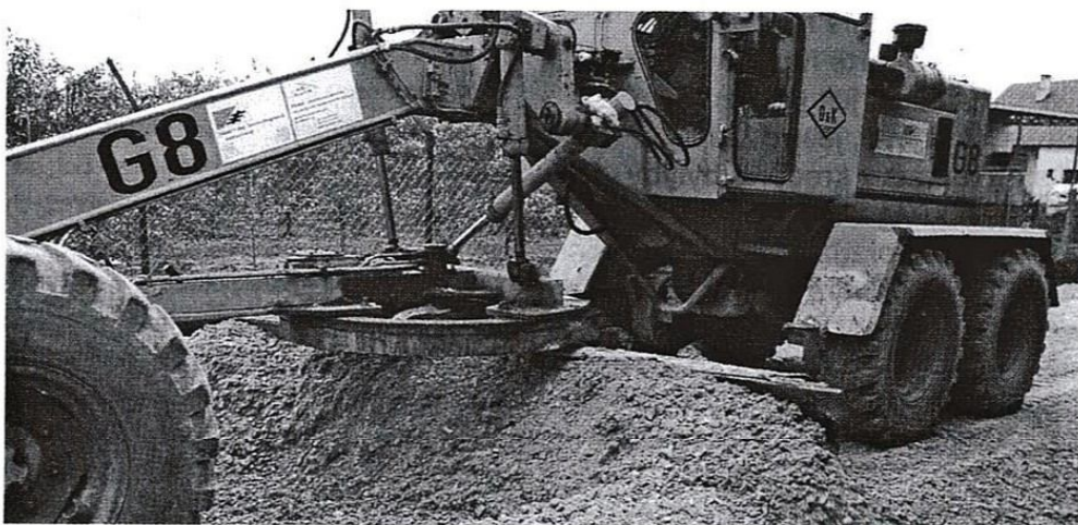
Prace modernizacyjne na ul. Wiślanej w Sobieniach-Jeziorach
